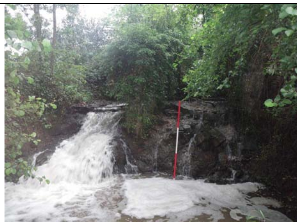
Photo 39 : Seuil formé sur la roche en place, pour rattraper la chute due à la rectification (amont du moulin Chamonard, FIL4)
