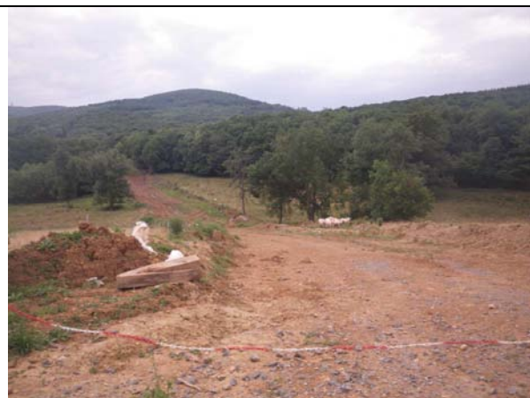
Photo 85 : mise en place d'un gazoduc (VER3)
