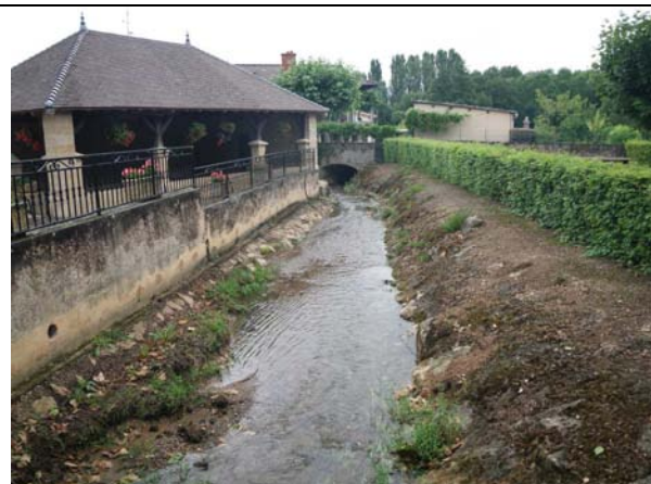
Photo 57 : secteur de mauvaise qualité dans la traversée de Davayé (DEN7)
