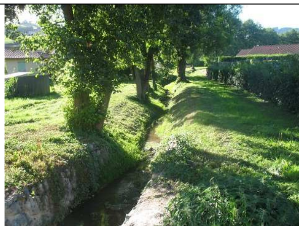
Photo 33 : rivière décaissée et recalibrée à l'aval du passage souterrain (CAR4)
