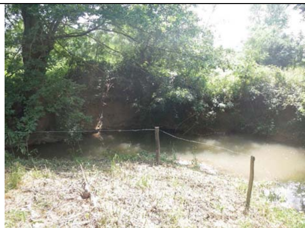
Photo 79 : Encoche d'érosion peu active en extérieur de courbe (du fait de la puissance de la rivière plus faible à ce niveau ainsi que de la cohésion de berge) (MOU15)
