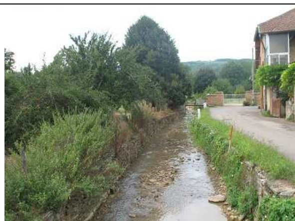
Photo 67 : La Mouge confinée entre deux murets au niveau du lieu-dit Pinago : peu de variation d'écoulement, colmatage total (MOU5).
