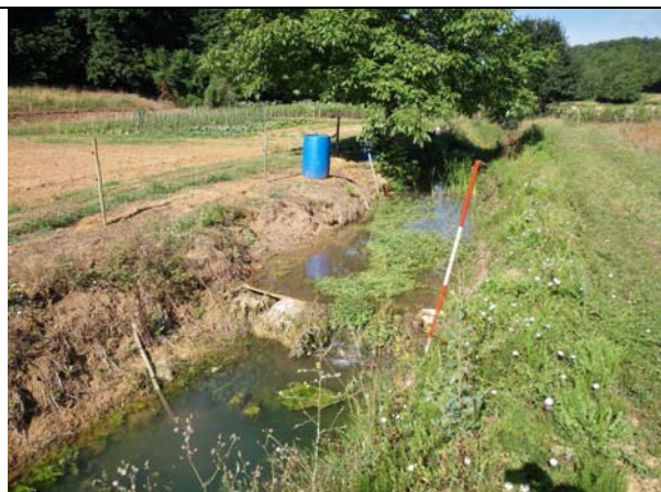
Photo 115 : Seuil destiné à l'irrigation des jardins et autres potagers. A noter les concrétions calcaires se formant sur ce dernier (BOU1)
