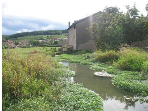
Photo 104 : zone de remous hydraulique d'un ouvrage à l'aval de Verzé (TAL2)
