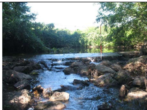
Photo 19 : ouvrage aménagé par une rampe en enrochements (PGR9)
