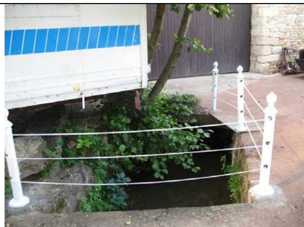
Photo 124 : entrée du passage souterrain de la Bourbonne sur le tronçon BOU8b
