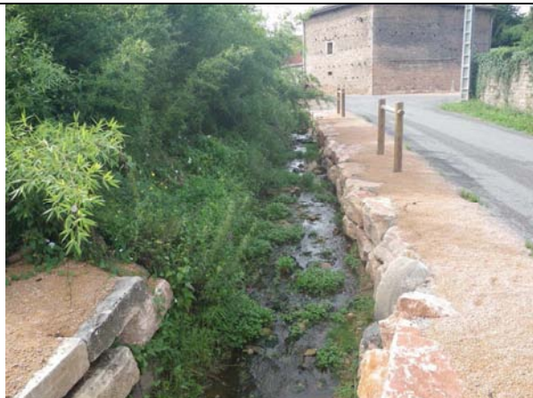
Photo 114 : Le ruisseau de Charbonnière artificialisé dans la traversée de Charbonnières
