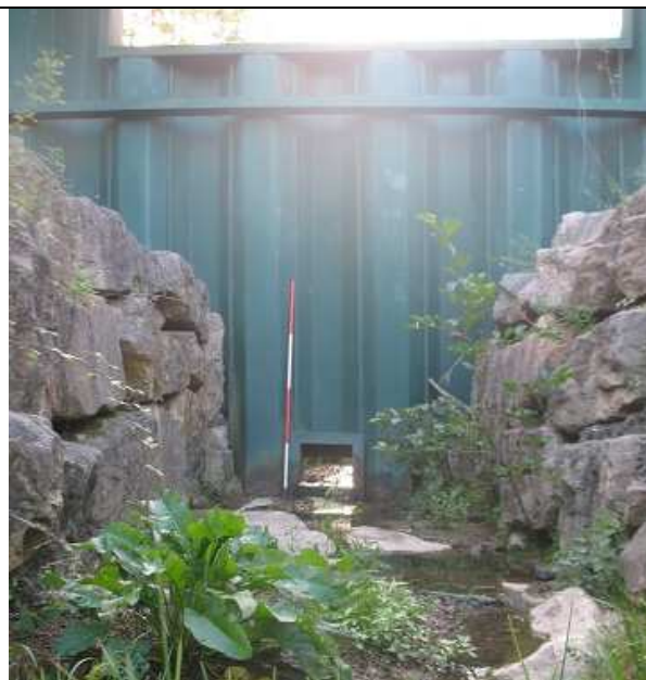
Photo 32 : ouvrage du bassin écrêteur de crues à l'amont de Pierreclos (CAR3)
