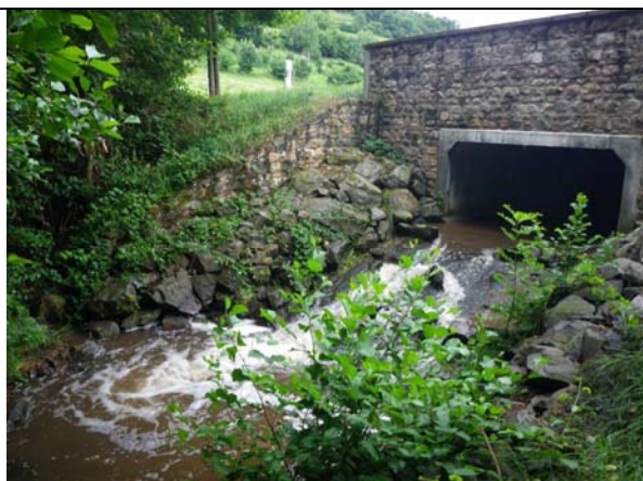
Photo 14 : Seuil sous pont au niveau « des Guttys » (PGR1) franchissables pour les truites fario
