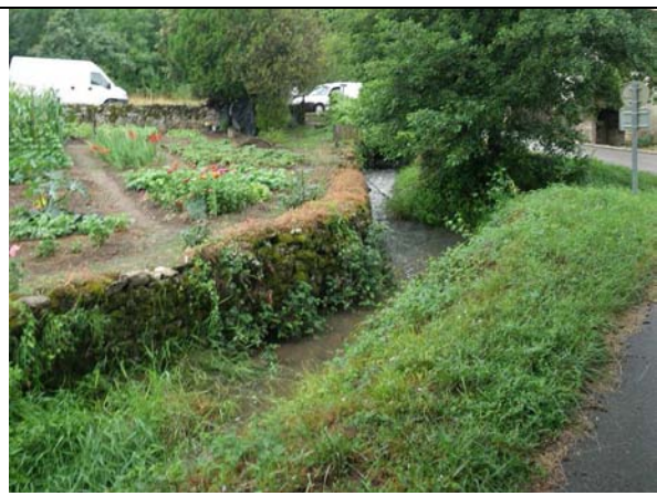
Photo 38 : Aménagements sur le Fil (FIL4) en berges (emmurements) et sur le fond (rampe béton)
