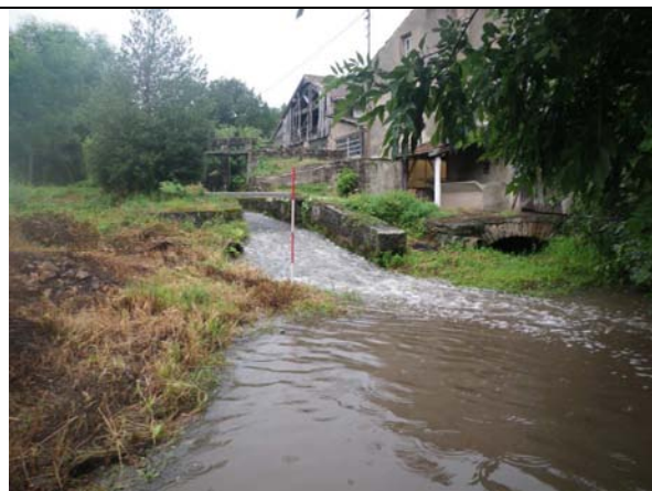
Photo 46 : ouvrage transversal du moulin Préaud (FIL6)
