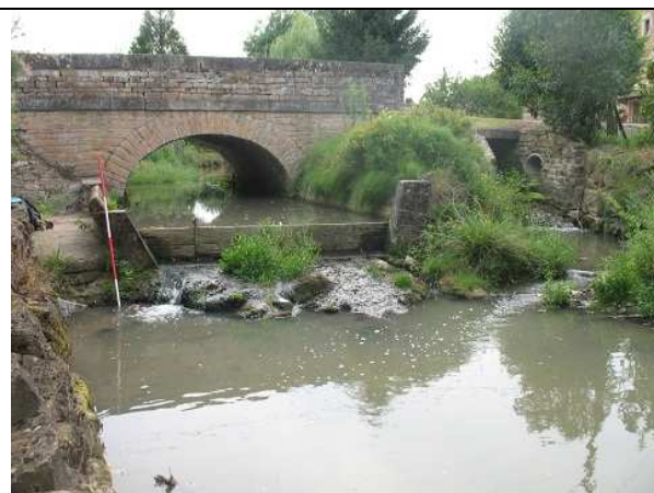
Photo 111 : Seuil « lavoir » sur le Talenchant à hauteur de Laizé.(TAL6)
