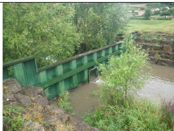
Photo 41 : L'ouvrage de rétention de crues à l'amont de la Roche-Vineuse (FIL 5)
