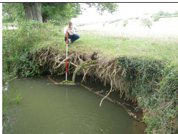
Photo 2 : Encoche d'érosion à l'aval d'un ouvrage (tronçon NAT03)
