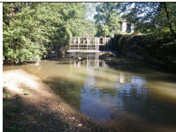
Photo 25 : Ouvrage automatisé de l'ouvrage de Balme (PGR16b) responsable du blocage du transit de matériaux grossiers venant de l'amont, probablement à l'origine de la reprise de l'activité érosive à l'aval de l'ouvrage.
