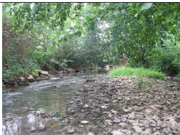
Photo 73 : Enrochements en rive droite en extérieur de courbe (second plan) et dépôt en rive gauche (premier plan) (MOU11)
