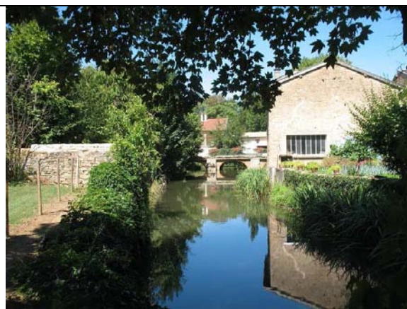
Photo 20 : La traversée de Prissé à l'amont du vannage automatique (PGR10)
