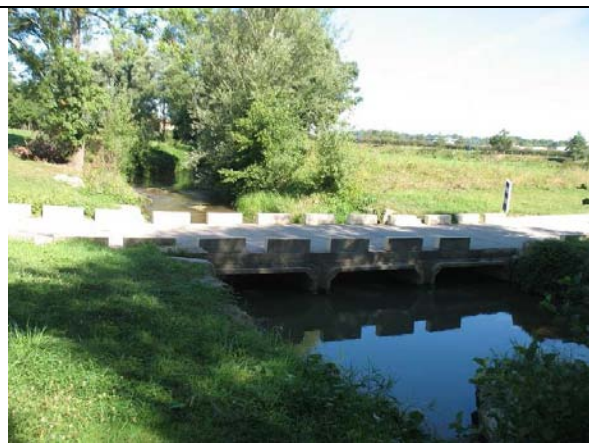
Photo 26 : Passage à gué à Mâcon-Loché (PGR17)
