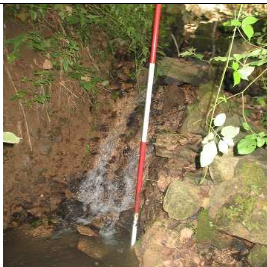
Photo 63 : Ouvrage détruit (hauteur de chute de 1.30 m env.). Le fond argileux demeure ainsi que quelques blocs de pierres (MOU2)
