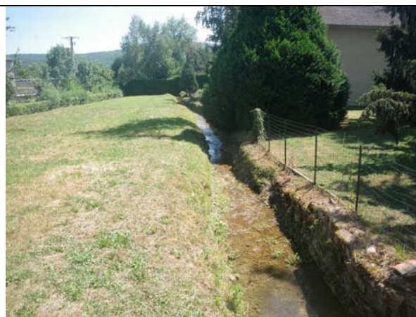
Photo 129 : L'Ail dans la traversée de Collongette. (AIL5)
