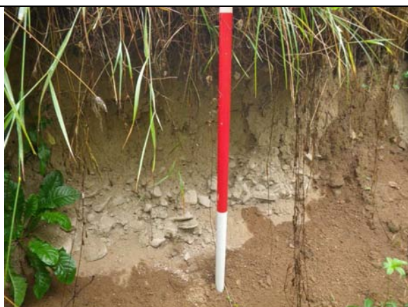
Photo 16 : Profil de berges graveleuses au niveau du tronçon PGR4
