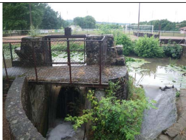
Photo 42 : ouvrage d'importante hauteur de chute à l'aval des terrains de sports de la Roche-Vineuse (FIL5)
