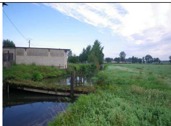
Photo 10 : Zone de remous à l'amont du seuil du moulin « l'Epine » (NAT17)
