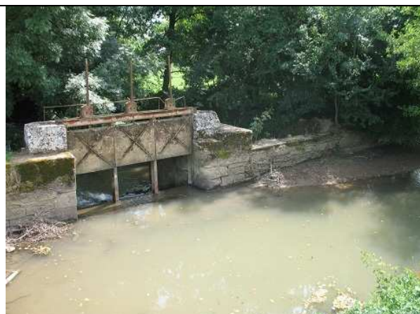
Photo 74 : Vannages relevés au niveau de l'ouvrage partiteur du moulin de la Croix (MOU12)
