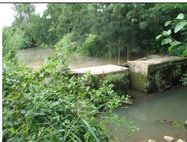
Photo 75 : ouvrage du golf de la Salle (MOU13a)
