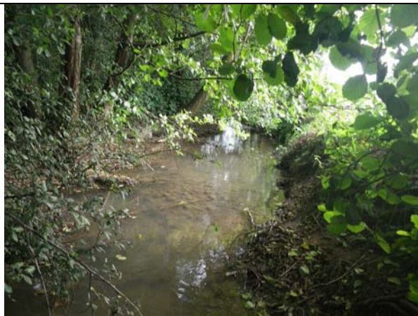
Photo 92 : Le ruisseau de l'Isérable sur le tronçon ISE5. A noter les éléments grossiers (galets calcaires anguleux pluri-décimétriques) ayant pour origine la colline sur le versant Est.
