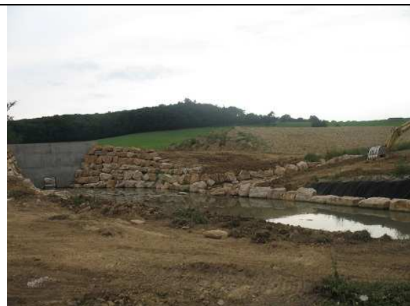
Photo 109 : ouvrage de rétention de crues en construction sur le Talenchant (TAL5)
