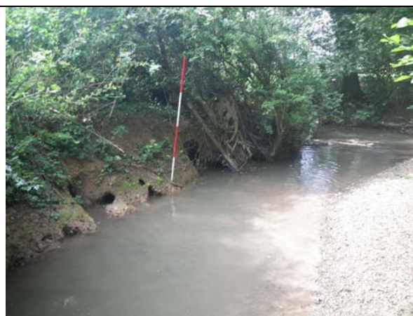
Photo 72 : terriers en rive gauche dans une berge argileuse (MOU9). L'impact de la faune sur les phénomènes d'érosion latérale peut être non négligeable (piétinement par le bétail, terriers de rongeurs...)
