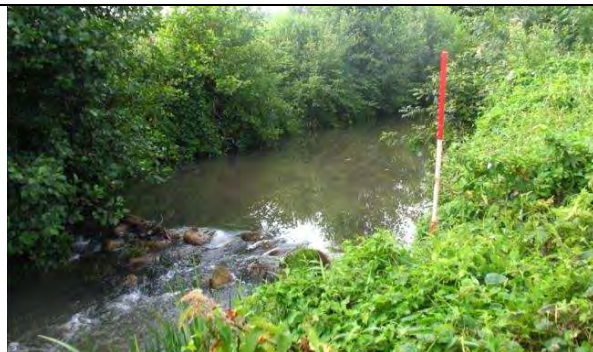
photo 8 : Seuil en pierres sur la Natouze (FP, FS)
