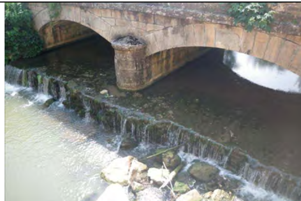
photo 5 : Seuil sous pont sur la Mouge (NFP, NFS)
