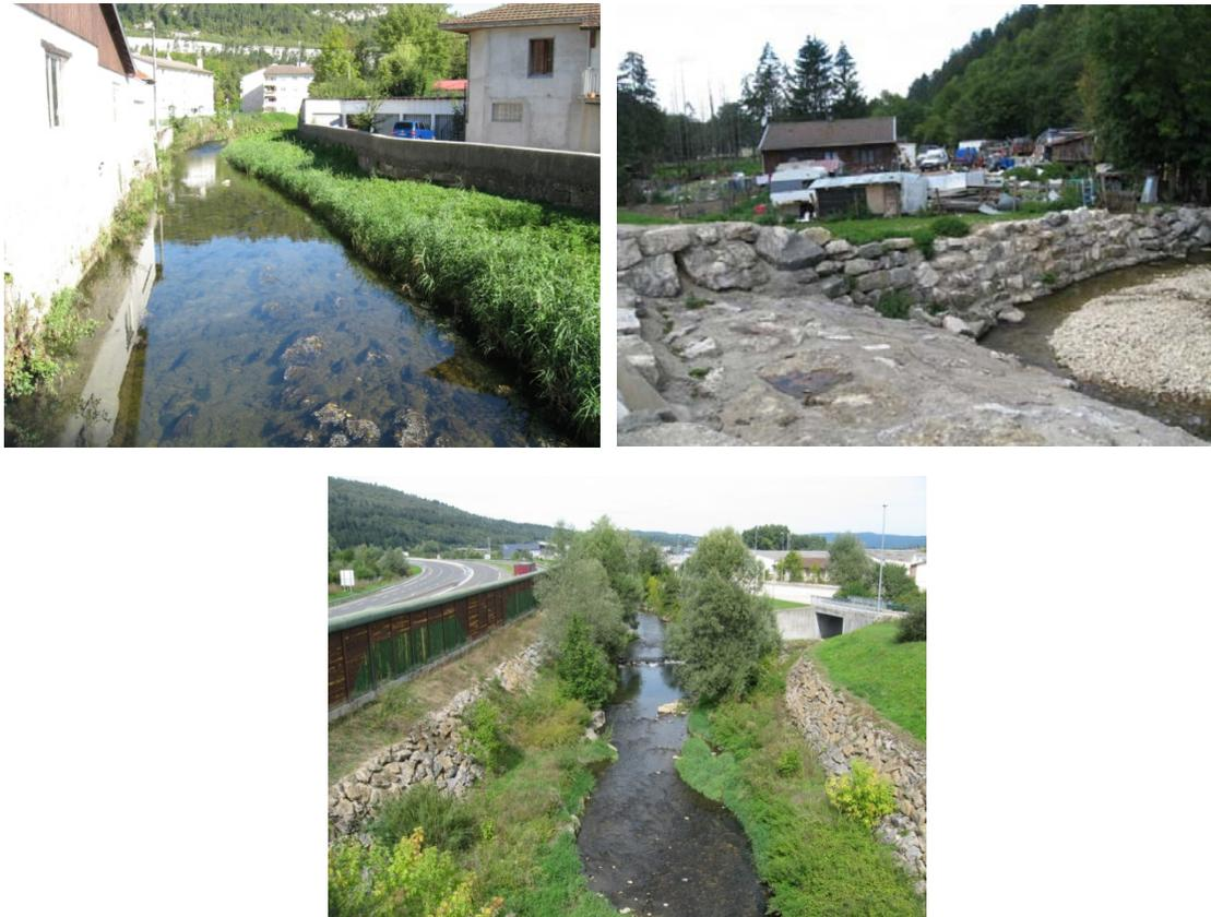
**Fig. 10. ILLUSTRATION DE PROTECTION DE BERGE (MUR BETON, ENROCHEMENTS LIAISONNES, ENROCHEMENTS LIBRES)**
