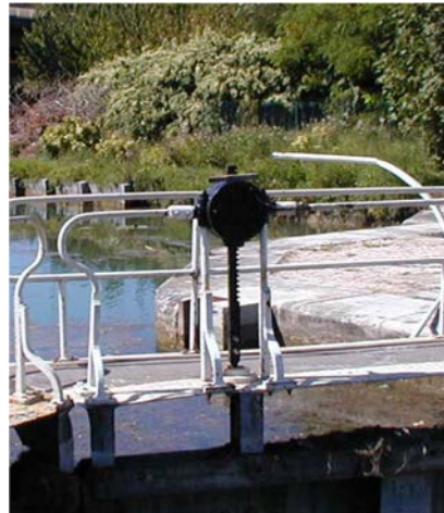
Photographie 5 : Ecluse de Larrey, détail de la crémaillère, vantelle porte gauche amont
