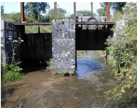
Photographie 2: La Vandenesse, prise d'eau de la Beaume (20)
