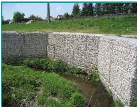
Mur en gabion en rive gauche du Muehlengraben à LONGEVILLE-LES-SAINT-AVOLD Photo SOGREAH, 2009
