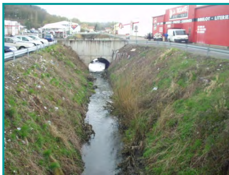
Rectification de la Rosselle dans la traversée d'une zone commerciale Photo SOGREAH, 2009
