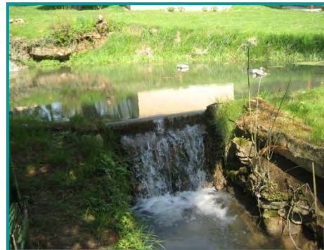
Petite mare aménagée par un riverain sur le Muehlengraben à LONGEVILLE-LES-SAINT-AVOLD : la chute perturbe fortement l'équilibre fonctionnel du cours d'eau Photo SOGREAH, 2009
