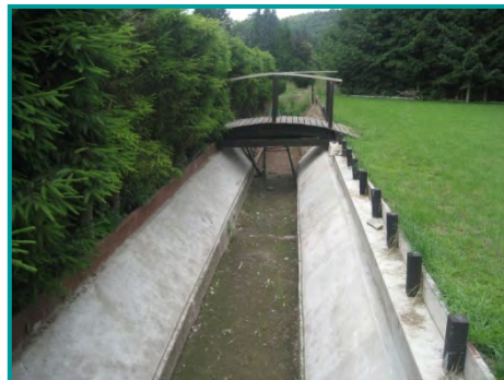
Berges du Herrenwiesgraben traitées par un riverain Photo SOGREAH, 2009
