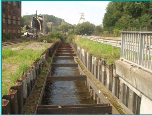
Palplanches le long du Merle Photo SOGREAH, 2009
