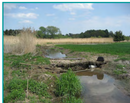
Ouvrages impactant la continuité biologique sur le Muehlengraben Photo SOGREAH, 2009
