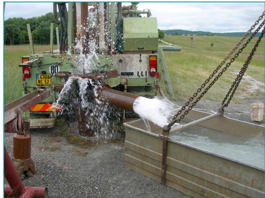
Mise en production de l'aquifère calcaire du Muschelkalk Photo ANTEA, 2005
