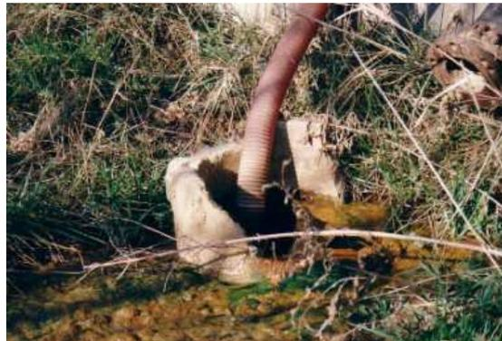
Figure 15 : Tête d'un forage mal protégé : source de pollution potentielle
