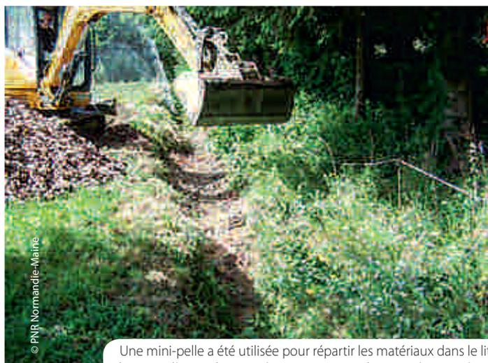
Une mini-pelle a été utilisée pour répartir les matériaux dans le lit du cours d'eau, selon une épaisseur variant de 60 cm à 1,20 mètre.
