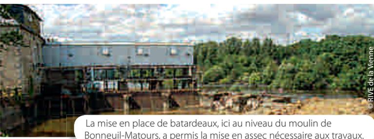
La mise en place de batardeaux, ici au niveau du moulin de Bonneuil-Matours, a permis la mise en assec nécessaire aux travaux.
