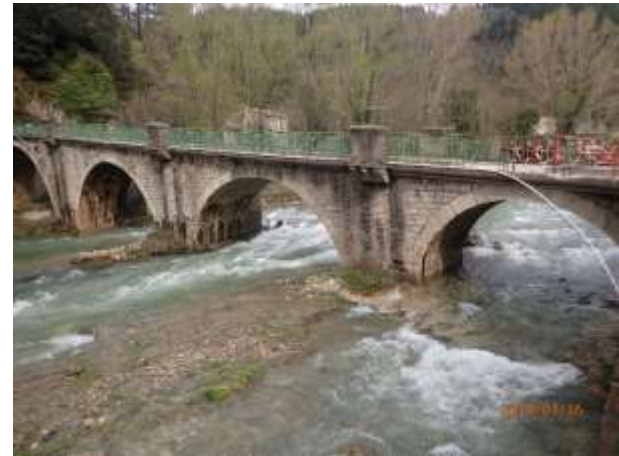
pont de la RD.8 E 13 sur l'Orb à Avène
