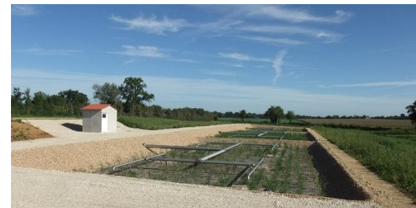
Station d'épuration de Magné – Photo : Département 86
