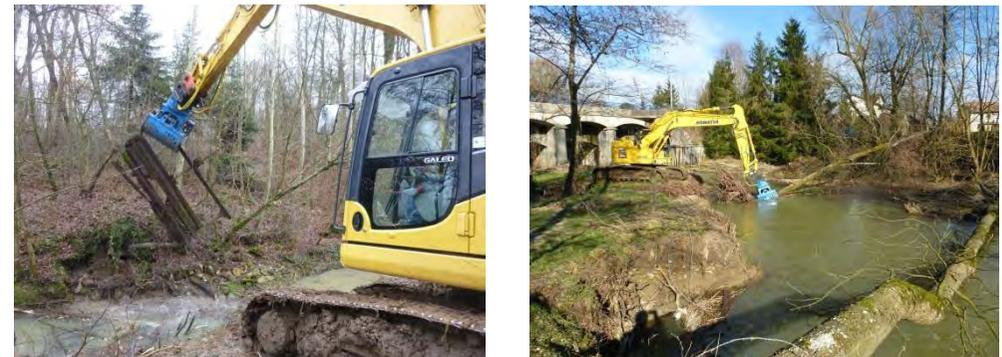
Figure 38 : Enlèvement d'une ancienne vanne d'écluse (à gauche), enlèvement d'embâcle.
