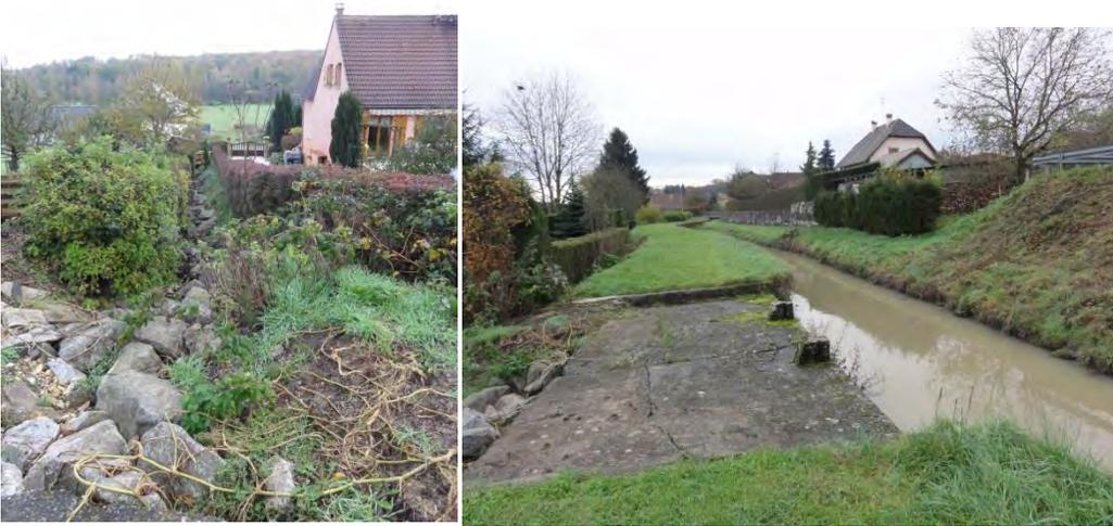
Figure 33 : Exutoire contraint en secteur urbanisé à Strueth destiné à recevoir les eaux débordantes de la rigole (à gauche) ; déversoir de la rigole à Strueth (à droite).
