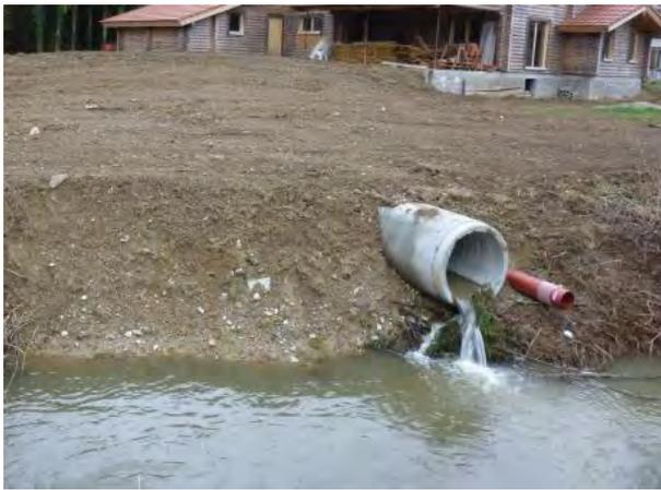
Figure 28 : Arrivée directe dans le Traubach d'un fossé busé en passage de la zone urbanisée
