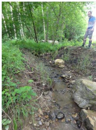
Figure 43 : Busage d'un ancien chemin forestier (à gauche) à Seppois-le-Haut, reconnexion du petit affluent à la Largue après l'enlèvement de la buse (à droite).
