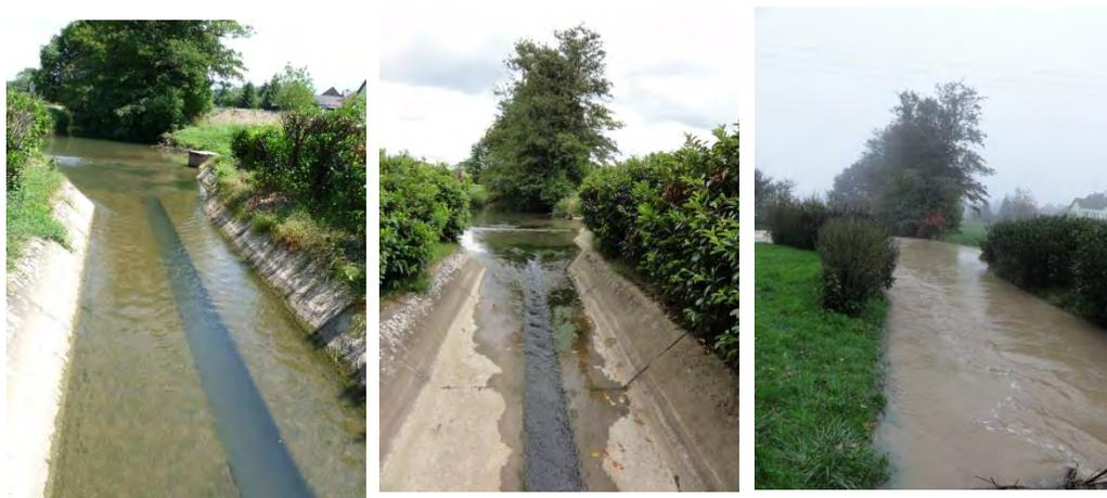
Figure 14 : Canal de mesure du débit restant dans la Largue, à gauche débit supérieur à 100l/s, photo du centre débit proche de 100l/s, photo de droite canal en saturation lors d'une crue
