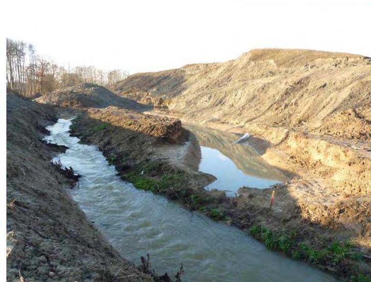
Figure 45 : Rectification du lit mineur\* de l'Elbach pour la réalisation du contournement routier de Retzwiller (ancien lit à gauche, nouveau lit à droite)
