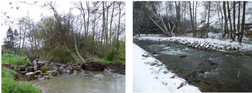
Figure 44 : Seuil\* effondré à Seppois-le-Bas, l'abaissement de la ligne d'eau menace la stabilité des ouvrages de génie civil (pont) en amont (à gauche). Stabilisation de la ligne d'eau par la création d'une rampe en enrochement sec franchissable (à droite).
