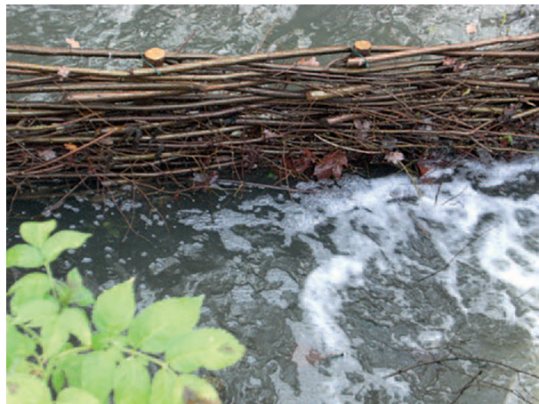
Mise en place de tressage pour protéger les berges (travaux du syndicat de rivière)
