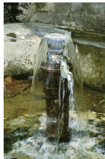
Figure 2 : Forage artésien captant la nappe astienne
