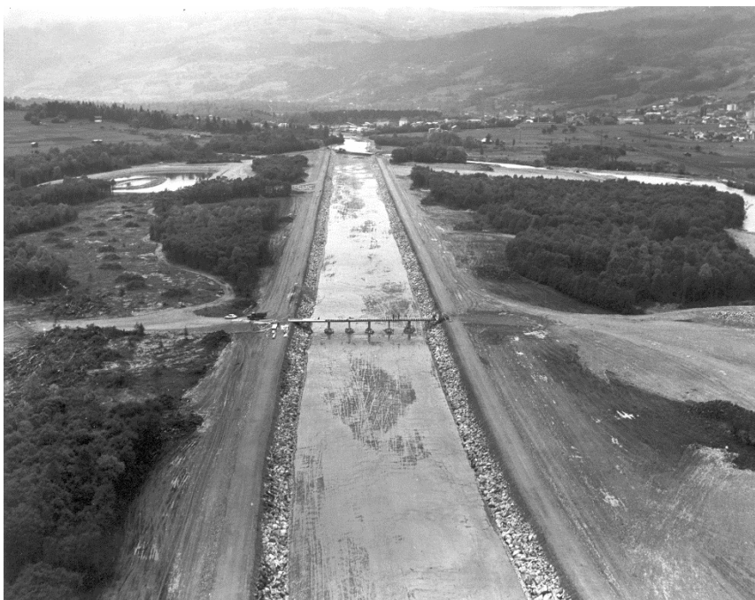
Photo 25 : Travaux du rescindement de l'Arve à Sallanches en 1966 (source : DDE)
