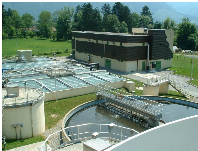
Photo 23 : Station d'épuration de Bonneville (source : SM3A)
