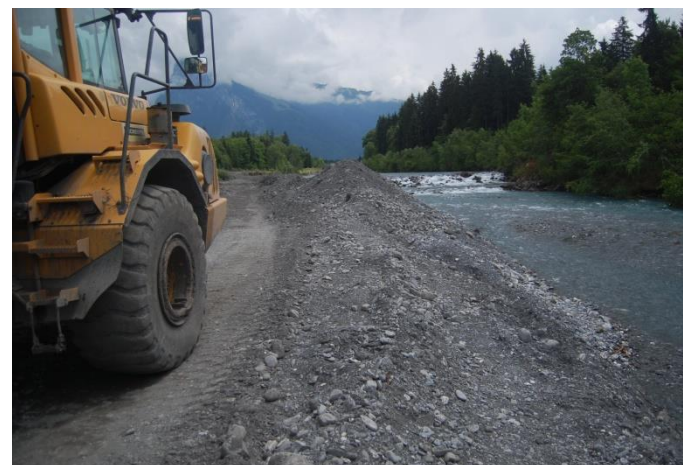
Photo 28 : Travaux de restauration du tressage et de réinjection de matériaux sur le Giffre (source : SM3A)
