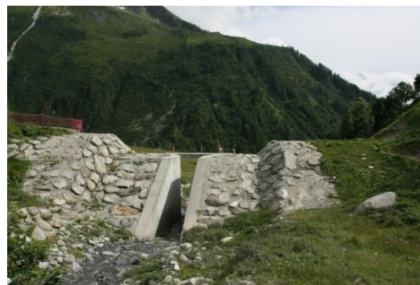
Photo 31 : Ouvrage de fermeture de la plage de dépôt du Tour à Chamonix (source : SM3A)
