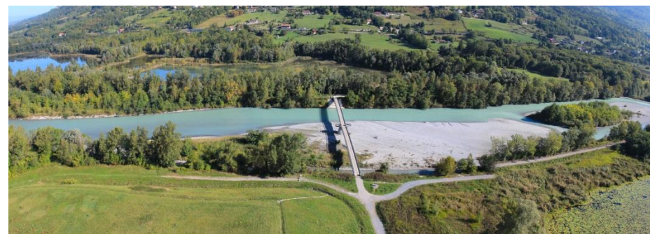
Photo 29 : Passerelle de entre Bonneville et Arenthon dans l'espace Borne-Pont de Bellecombe réalisée à l'issue d'une démarche visant conjointement la protection des milieux naturels et leur valorisation auprès du public (source : SM3A)
