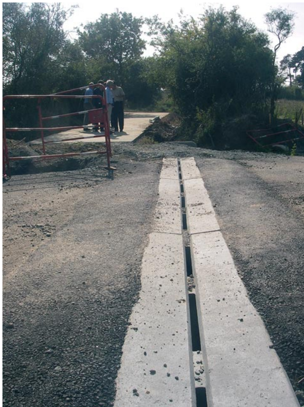
Mise en place d'une buse spécifique pour le passage des batraciens dans le cadre de l'aménagement d'une zone d'activités à Guérande.
