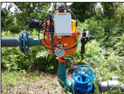
Afin d'automatiser le fonctionnement du goutte à goutte, un programmateur a été installé. Il commande une électrovanne à la sortie de l'hydrant, juste devant le filtre autonettoyant.
