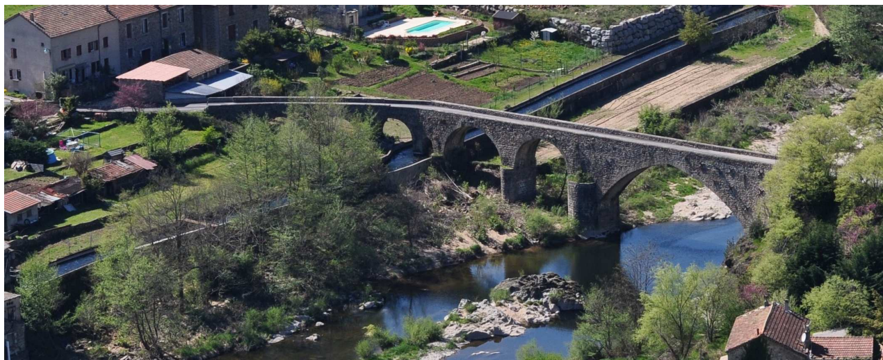
Pont enjambant le canal alimentant le Moulinon à St Sauveur de Montagut (photo C. Fougierol)
