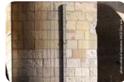
L'échelle limnimétrique du pont Sanitas sur le Cher à Tours dans l'Indre-et-Loire
