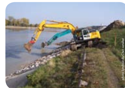
Les travaux sur la digue de Saint-Avertin sur le Cher en Indre-et-Loire en octobre 2008
