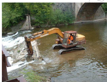
Arasement du seuil de Grand Pont à Lempdes-sur-Alagnon
