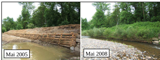
Ouvrage de génie végétal
