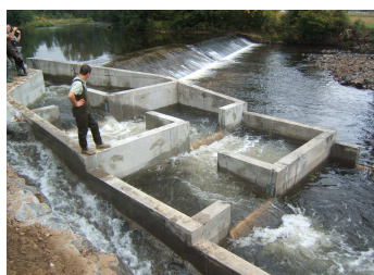
Réalisation d'une passe à poisson sur le seuil de Notre Dame à Massiac
