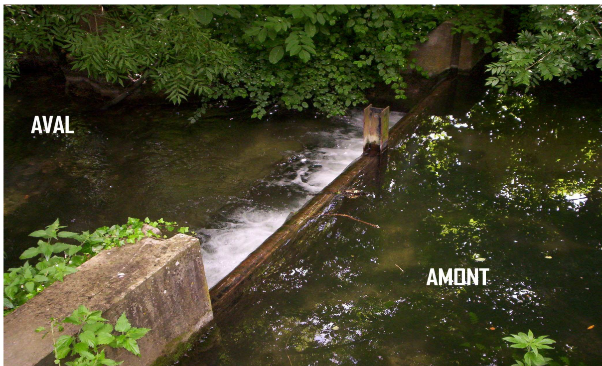
Ouvrage à madrier sur la Boutonne à Saint-Jean d'Angély
