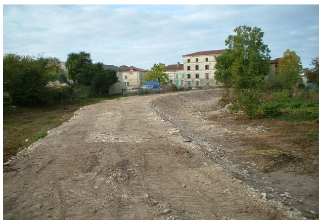
Restauration d'une digue par le SIBA. Source SIBA
