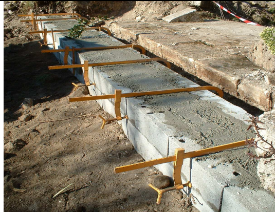
Construction des deux murs de parpaing avant leur recouvrement par les pierres d'origine
