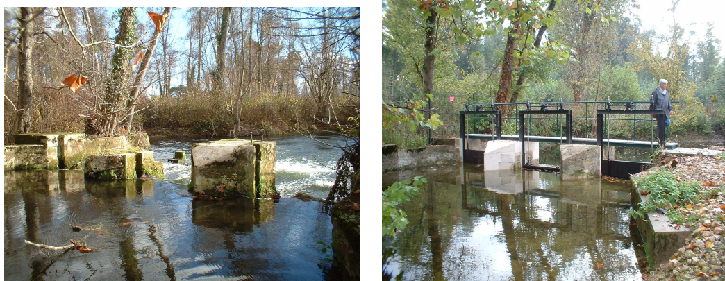
Travaux de restauration de l'empellement du moulin de Vervant. Source : SIBA
