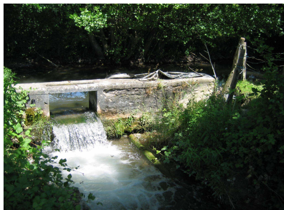
Après travaux d'entretien
