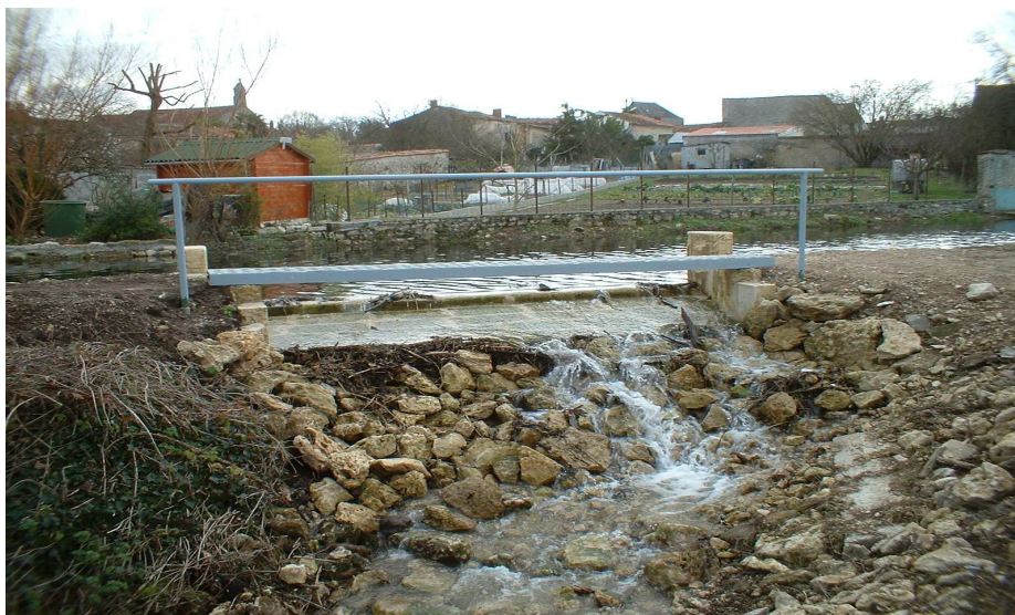
Déversoir rattaché aux moulins Eturnaud et Cousinery, en hiver, l'eau s'évacue vers le cours d'eau naturel
