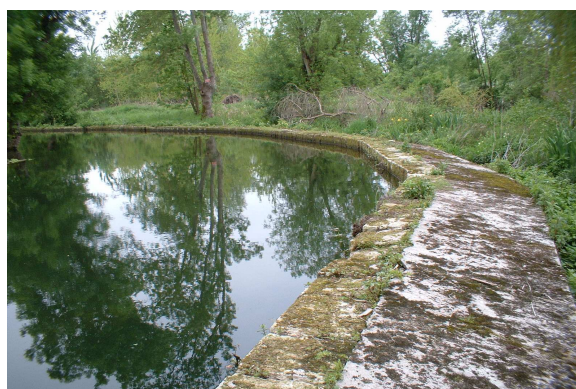
Déversoir en arc de cercle de 60m linéaire (Déversoirs de la Boutonne). Source : SIBA
