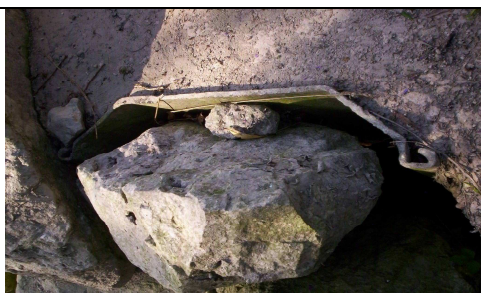
Palplanche et rocher pour lutter contre l'érosion au niveau d'un déversoir du canal Saint-Eutrope à Saint-Jean d'Angély
