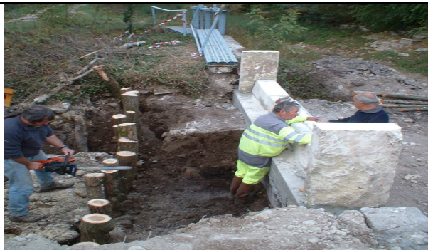
Mise en place des pieux avant leur recouvrement par le géotextile
