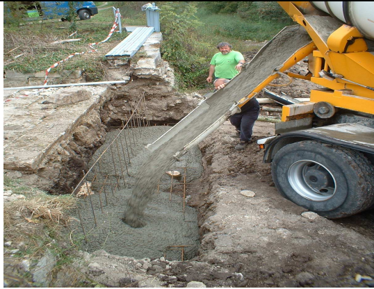
Mise en place du béton dans la fondation sur les pieux et le maillage métallique
