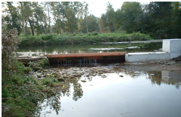
Ouvrage à madriers et déversoir sur la Boutonne. Source : SIBA
