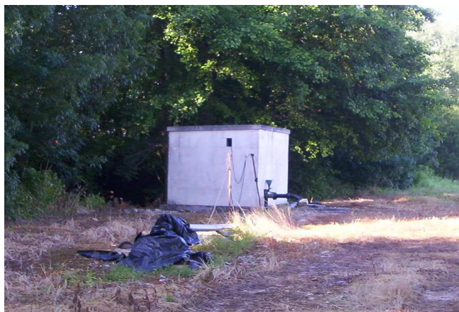
Station de pompage sur un bief de la Boutonne
