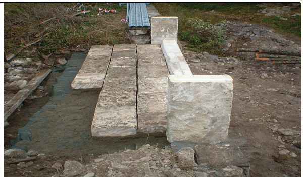
Pose des pierres d'origine sur le géotextile avant la mise en place d'enrochements en aval
