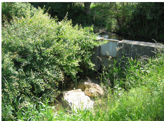
Avant travaux d'entretien de la végétation du SMBB
