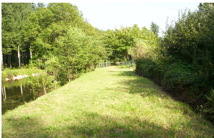
Digue avec de la végétation sur le canal Saint-Eutrope à Saint-Jean d'Angély
