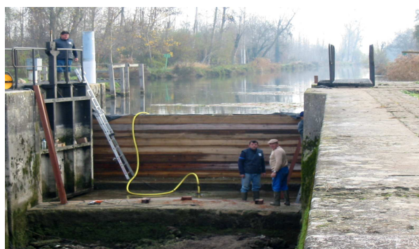
Travaux de l'écluse de Voissay. Source : CG
