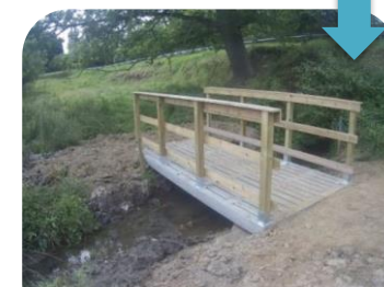
Après travaux Berges restaurées
