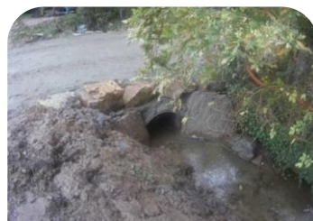
Après travaux Circulation piscicole restaurée
