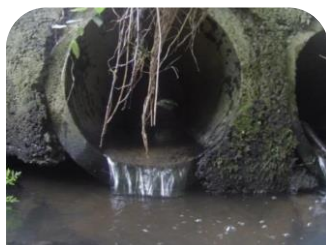
Avant travaux Circulation piscicole limitée
