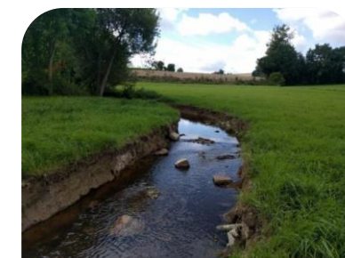
Après travaux Lit du cours d'eau restauré Faciès d'écoulement recréés
