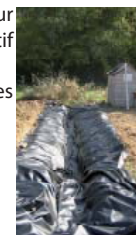
Installation du Venturi
