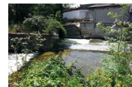
Berge effondrée à Marseille, Boulevard Heckel, 2015, © SIBVH
