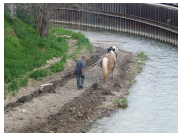
Intervention d'un cheval pour suppression d'un atterrissement au Pont Lamagnon (mars 2014 © SIBVH)
