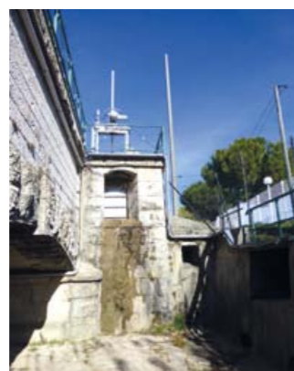
Surverse du canal de Marseille dans le Jarret à Allauch © SIBVH
