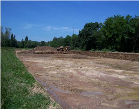
Figure 15 - création du bassin d'orage de Prissé
