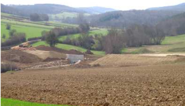
Figure 17 - construction du bassin d'orage à Laizé
