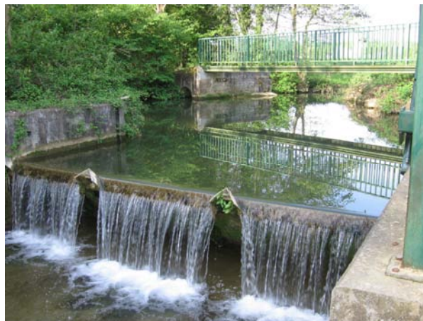
Figure 18 - vannage automatique à Montbellet (Bourbonne)
