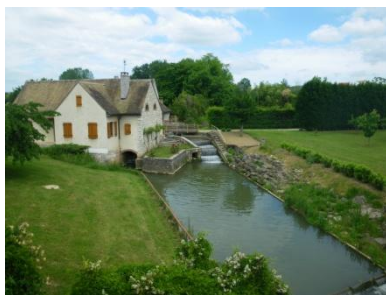
Ouvrage transversal sur la Thalie
