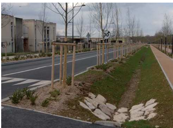
Exemple de développement de techniques alternatives au « tout réseau » pour l'assainissement pluvial des voiries (source : Grand Lyon)
