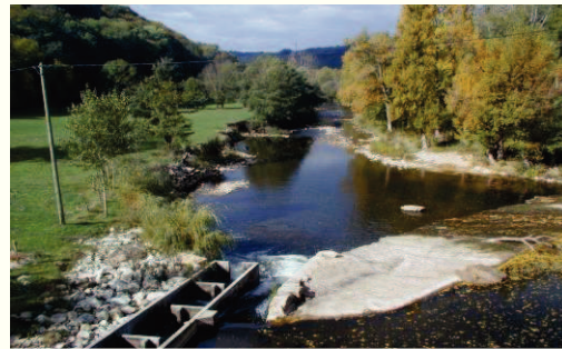
Photo n° 13 : chaussée du Moulin du Pont-Neuf, avec front d'érosion de la berge rive gauche (2007 - SIAV2A)
