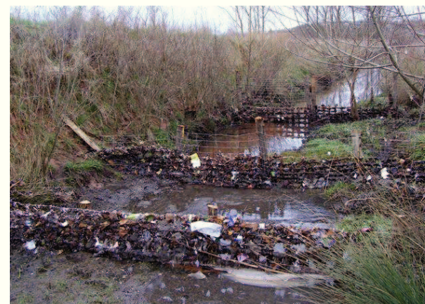
Photo 15 : Photo d'un "dégrilleur artisanal" réalisé par la Cellule opérationnelle rivière du Grand Rodez et installé en sortie d'un exutoire pluvial sur le ruisseau du l'Auterne afin de piéger une partie des déchets
