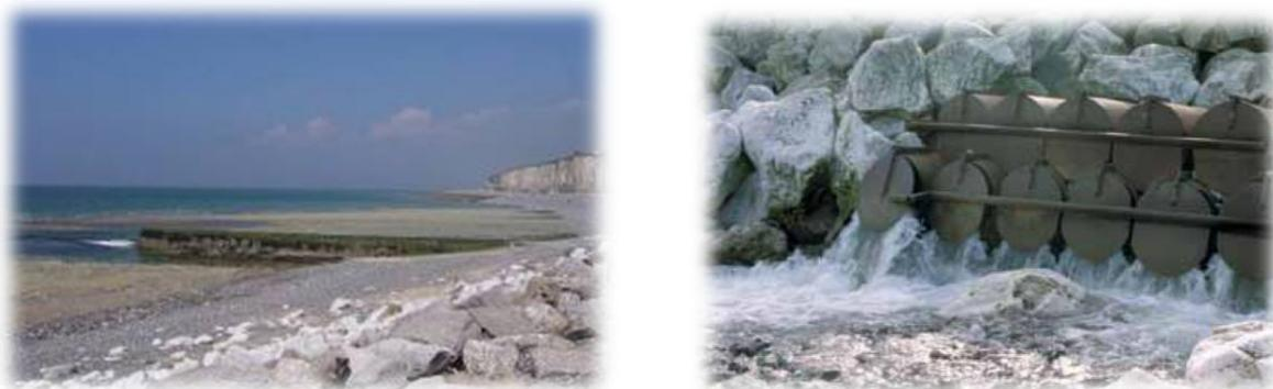
**Figure 57 : La buse à l'exutoire de l'Yères avec le dispositif de franchissement en orgues de Staline**
