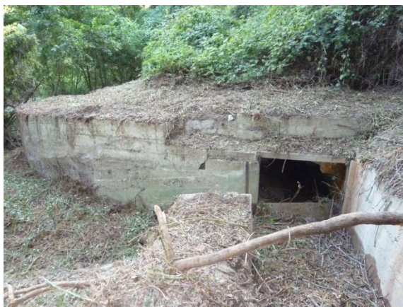
Vue de l'ancienne prise d'eau en rive droite
