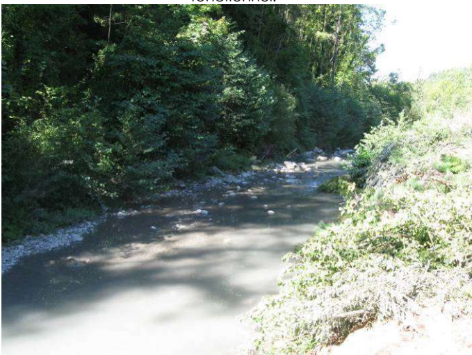
Aspect représentatif du Roubion à l'amont de Bourdeaux – lit encaissé et peu fonctionnel.
