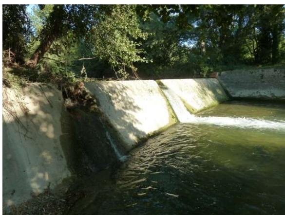
Vue du seuil depuis l'aval en rive droite
