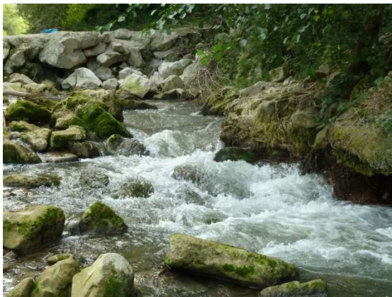
Radier artificiel en enrochements et sur la marne en aval du seuil
