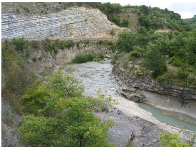
Verrou rocheux à l'amont de la confluence avec l'Eyzarette. Ce secteur est franchissable en hautes eaux.
