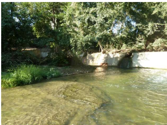
Vue du seuil en rive droite depuis l'aval au centre du chenal – affleurements de marnes au 1 er plan
