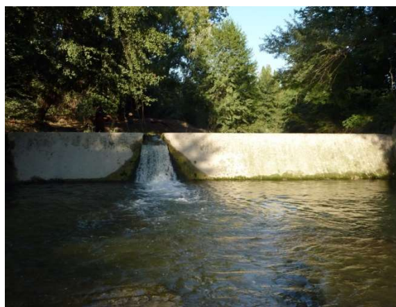
Vue d'ensemble du seuil depuis l'aval au centre du chenal
