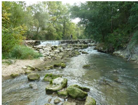
Aval du seuil vue depuis la rive gauche- affleurements rocheux
