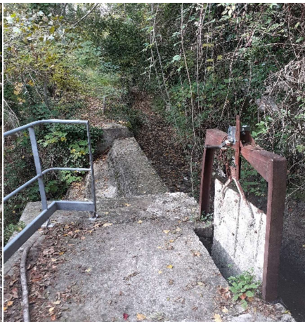
Entrée de la prise d'eau
