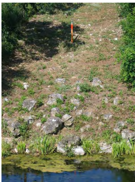
A gauche - Un piézomètre de digue de la CNR à Péage-de-Roussillon (38). Ce type d'ouvrage permet de surveiller le niveau d'eau dans les digues (© F. Paran)
