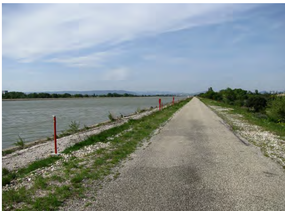
Vue du canal de dérivation à Donzère-Mondragon sur la route de digue jalonnée par les piézomètres CNR de surveillance (© F. Paron)
