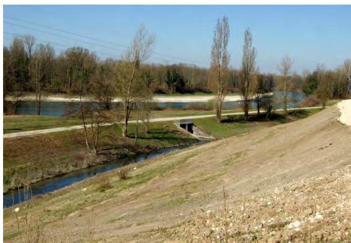
A gauche- Un contre-canal en pied de digue entre canal dérivation et Vieux-Rhône à proximité de Brégner-Cordon (01). Les contre-canaux recueillent les eaux de fuites des digues et potentiellement des eaux souterraines (© F. Paron)
