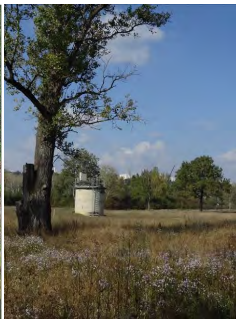
A gauche - Un piézomètre de digue de la CNR à Péage-de-Roussillon (38). Ce type d'ouvrage permet de surveiller le niveau d'eau dans les digues (© F. Paran)
