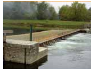
Barrage à aiguilles sur le Cher à Chisseaux, octobre 2009 (37) © Romain Suaudeau
