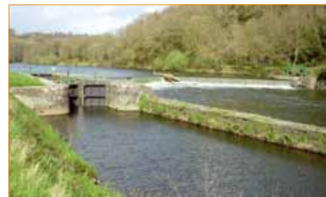
Écluse et seuil sur l'Aulne canalisée à Lennon, avril 2007 (29) © Romain Suaudeau
