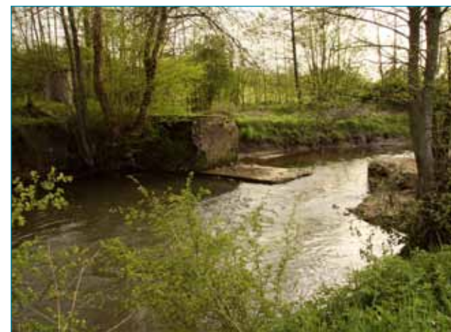
La Risle après démantèlement d'un ouvrage, mai 2008 (61) © Bernard Rousseau
