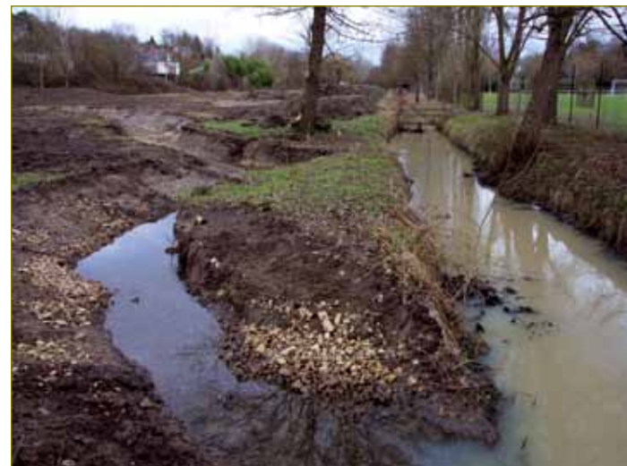
Le Marolles pendant les travaux de renaturation en janvier 2009 avec nouveau et ancien lit (37) © Jonathan Leproult
