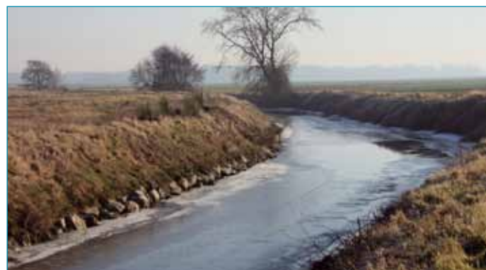
Enrochements et recalibrage sur le Dhuy à Sandillon (45) - © Bernard Rousseau
