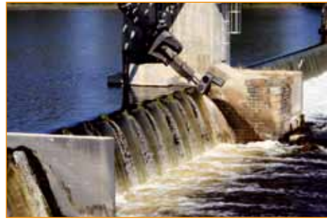
Barrage sur le canal de Roanne, juillet 2008 (42) © René Fessy
