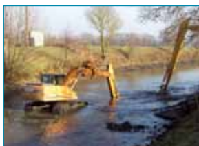
Travaux sur l'Aauthion (49) © Vincent Molinier
