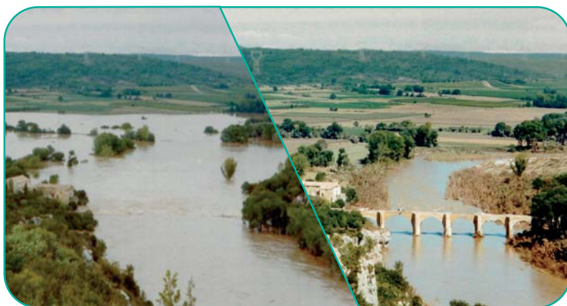
Le Pont St Nicolas, pendant et après la crue
