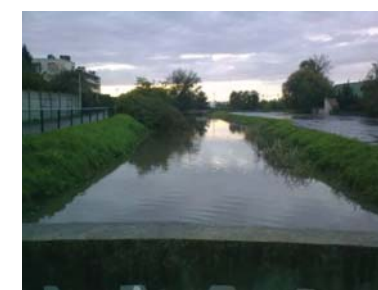
Bassin des Cressonnieres plein à 100%, le 23 10 2010
