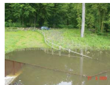
Digue de la Chasse ouvrage saturée le 21 mai 2003
