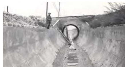
Travaux de canalisation de la rivière Photo d'archives P. Douzenel, 1960
