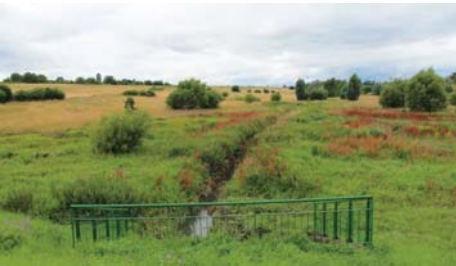
Bassin Bourguignon 2 à Ezanville (SIAH)
