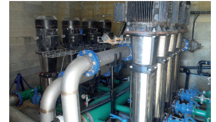
Pompes de distribution des eaux du bassin Golf Blue Green de Sainte-Maxime
