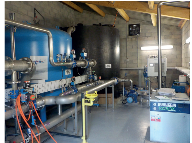
Traitement tertiaire pour une capacité maximale de 200 m 3 /j en qualité A Exploitation en régie : de l'ordre de 5 h par semaine en période d'irrigation (hors analyses) Investissement initial de 410 000 € HT [ données SIVOM du Littoral des Maures ]
